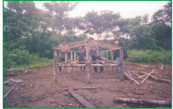
Fig. 4: Instalación de soportes de las parihuelas.
